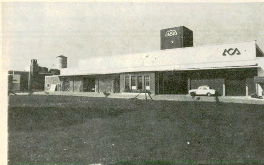
Más de medio centenar de personas trabajan en la planta de Señalamiento, en Villa Zagala, en la cual se pueden producir anualmente más de 50.000 señales viales.
